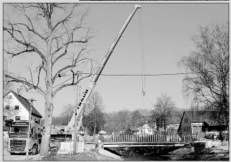
Aus den vier Teilen werden die 3,50 Meter breite Fahrbahn, die keinen Begegnungsverkehr zulässt. Flussabwärts wird ein 2,50 Meter breiter Geh- und Radweg und flussaufwärts ein 1,50 Meter breiter Gehweg gebaut.
