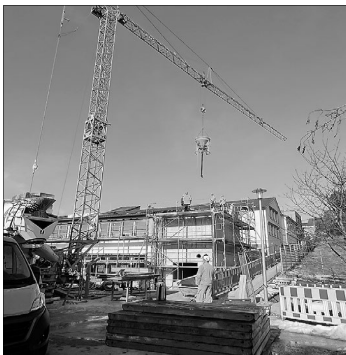
Die Betondecke über der Nahwärmezentrale am Südbau wurde vergangene Woche fertiggestellt.
