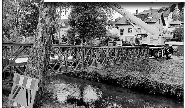
Am Nachmittag wurde die Brücke mit dem Kran an Ort und Stelle positioniert.
