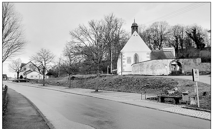
Während der ersten Bauphase bleibt der südliche Eingang vom Kirchhofweg aus bestehen.
